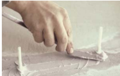
Anclando los portes
