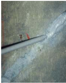
Sellando la grieta
