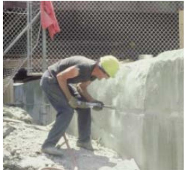
El material de acabado se lija luego de reparar la grieta. Este paso sólo es necesario si la apariencia es una prioridad. Si la fachada del concreto no está expuesta, este proceso no es necesario.
