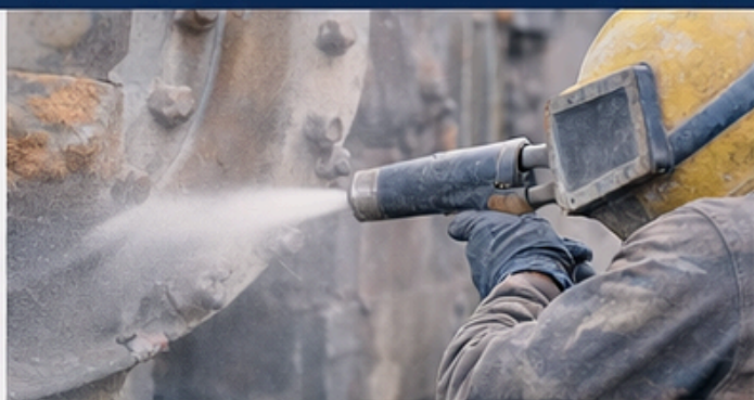
Limpieza mecánica en zinc.
